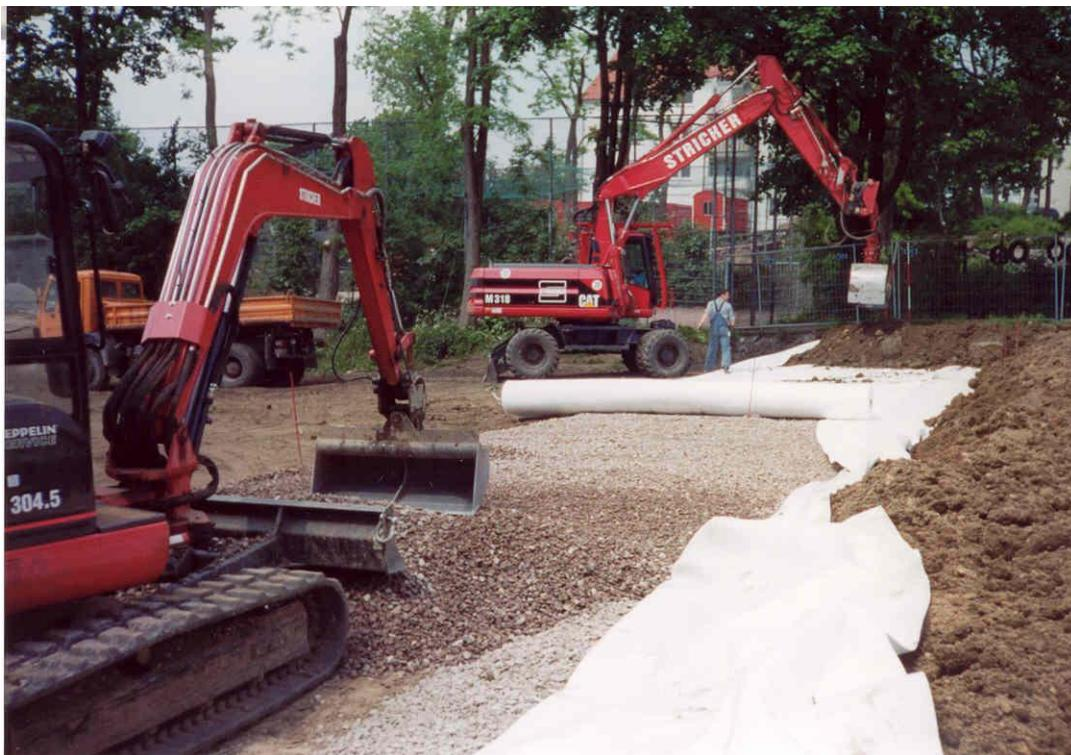
Abdeckung für die Unterbindung des Wirkungspfades Boden-Mensch
