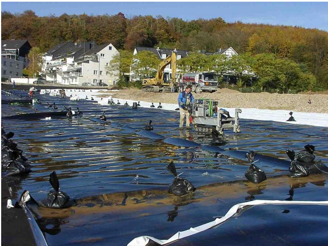
Abdichtung mit Kunststoff-Dichtungsbahnen für die Unterbindung des Wirkungspfades Boden-Grundwasser
