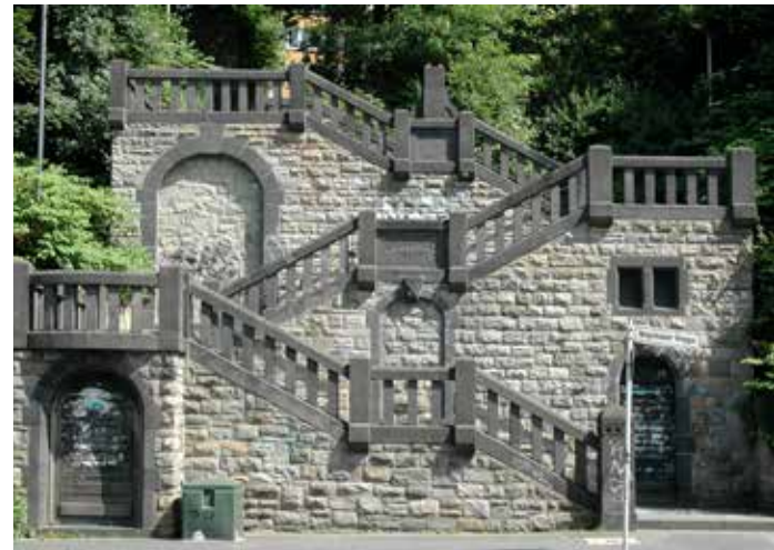
02 Denkmalgeschützte Vogelsauer Treppe in Elberfeld-West, Quelle: Stadt Wuppertal
