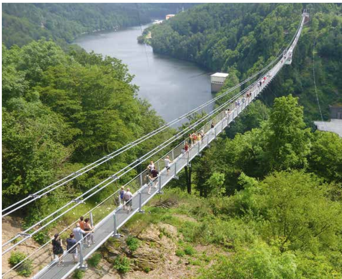
01 Ein neues Brückenbauwerk, Quelle: Firma hochkant GmbH
