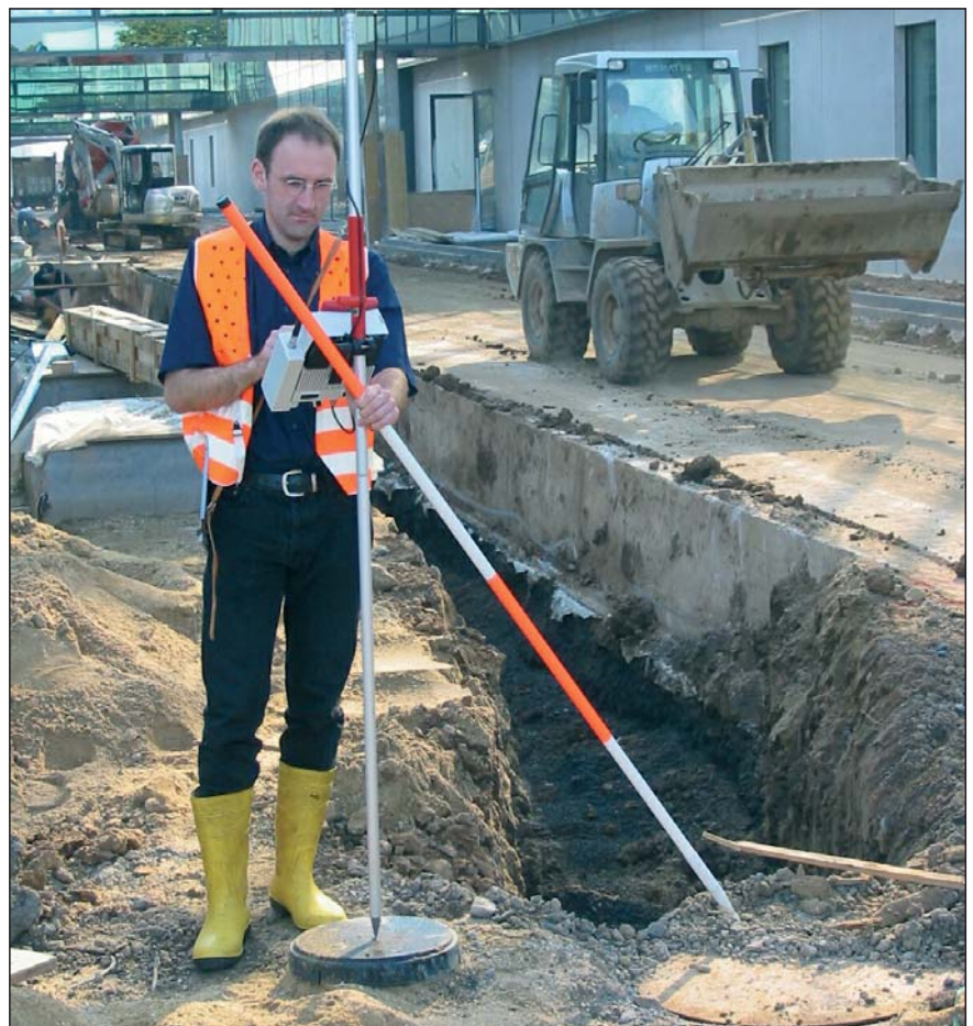
Abb. 3: GPS-Punktaufnahme im Gelände
