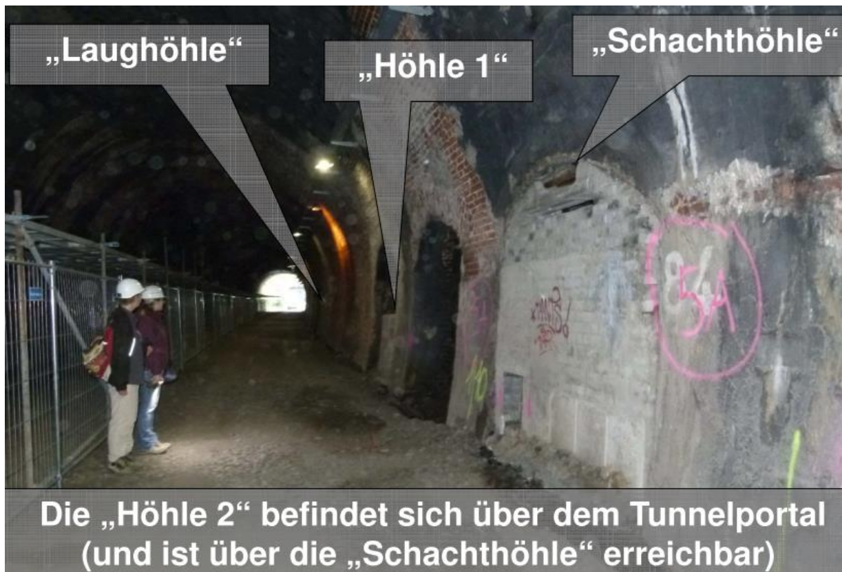
Abbildung 14: Lage der Höhlen im Tunnel Dorp
